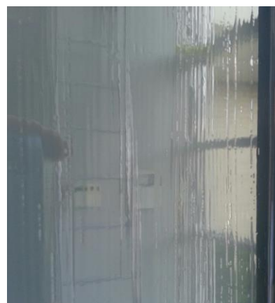
defecten kwastapplicatie
